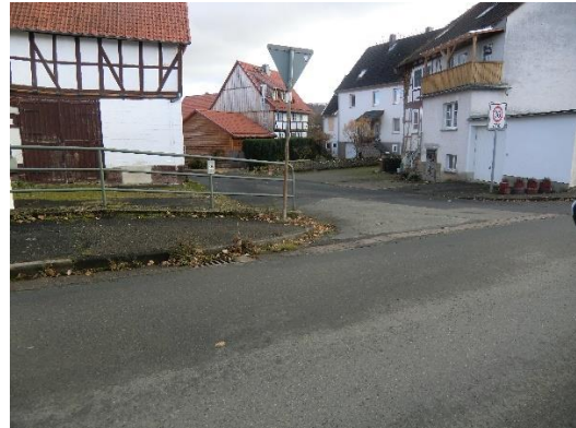
Einmündungsbereich „Lange Straße“
