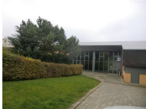
Unterer Bereich des Grünstreifens ist zu steil.
